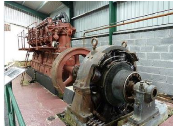
Generador eléctrico accionado por un motor diesel
